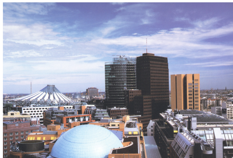
Vista geral de Potsdamer Platz com a cúpula do IMAX em primeiro plano
