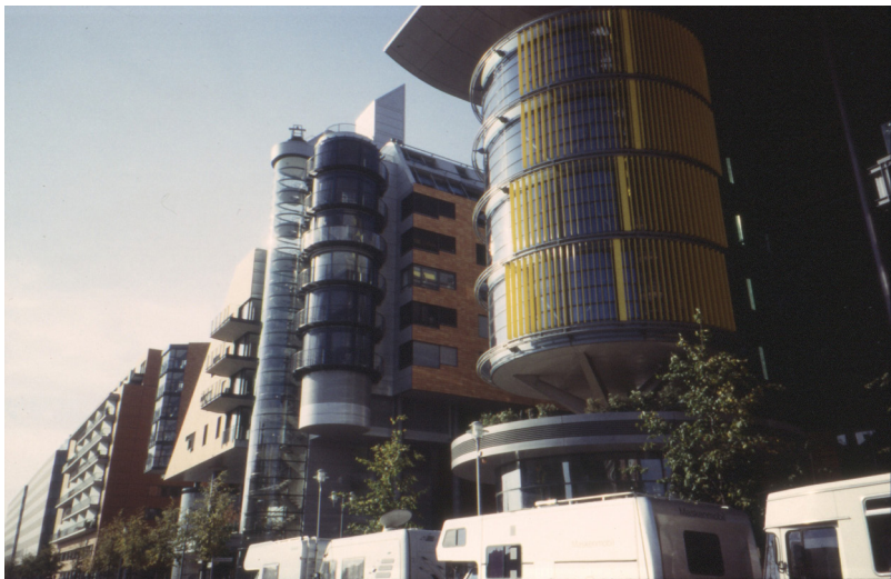
Prédio do conjunto Daimler-Benz, Arq. Richard Rogers
