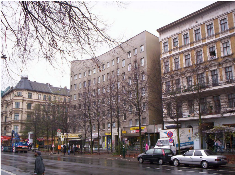
Rua de Kreuzberg restaurada, com prédio do Arq Álvaro Siza ao meio: “Bonjour Tristesse”
