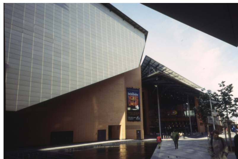
Acesso às salas de cinema na Potsdamer Platz
