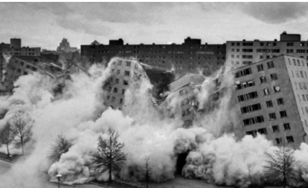
Implosão de blocos habitacionais Pruitt Igoe em Saint Louis, EUA, 1971.
